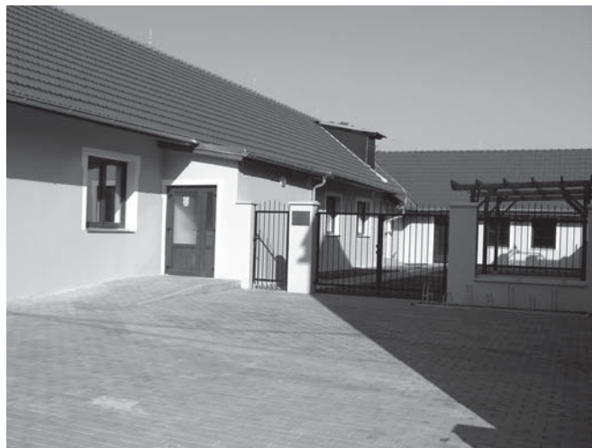
Foto po realizaci
