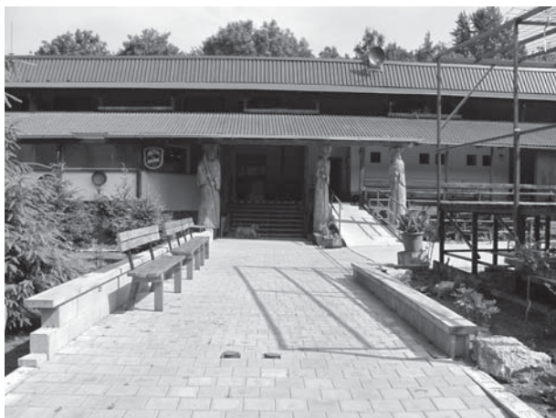
Foto po realizaci
